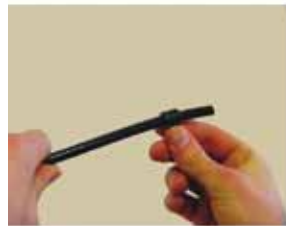
1. A szorítóhüvelyt felhelyezzük a csőre még a tágitás előtt.
