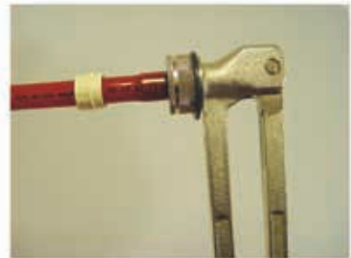
3. A csövet feltágítjuk többszöri tágitás-forgatással
