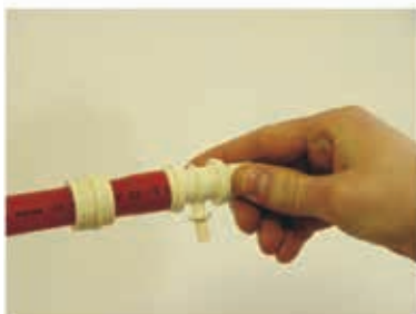
4. Az idomot betoljuk a feltágított csőbe ütközésig.
